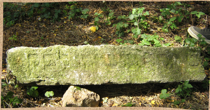
Vstupní portál před rekonstrukcí
